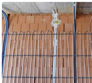
Система Uponor Plaster, стена
