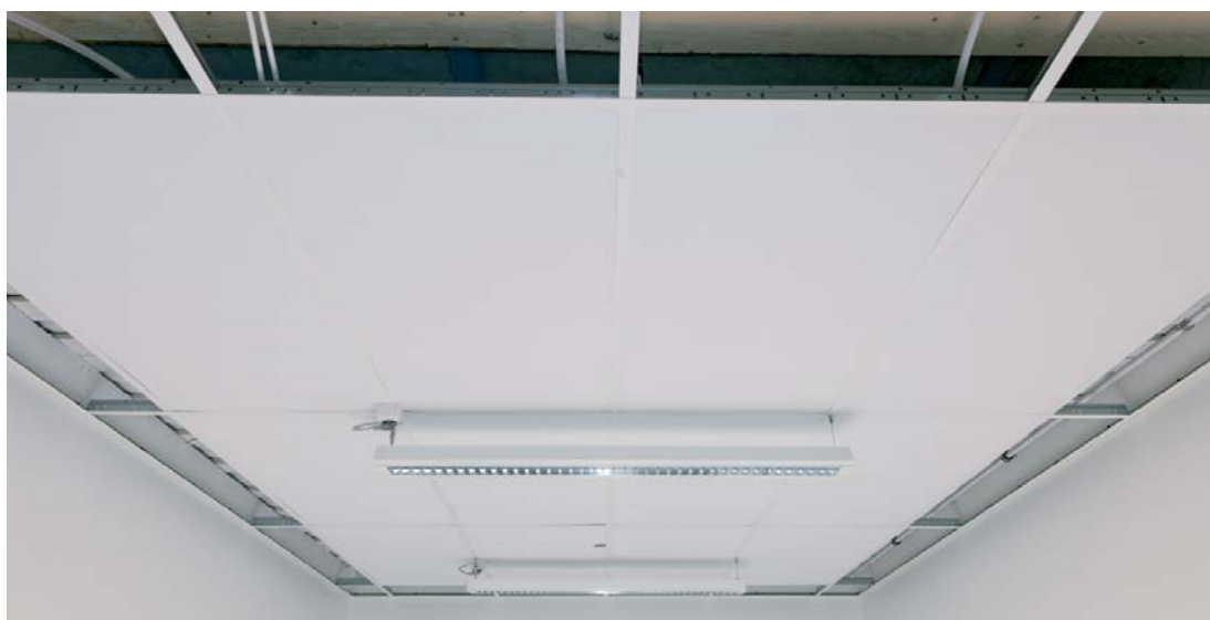
Полностью установленная подвесная потолочная система Upronor Comfort без сплошных панелей, которые будут установлены по периметру потолка.
