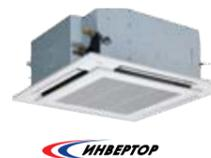
Отличное решение для помещений с подвесным потолком. Кассетный блок полностью скрыт за потолком, видна лишь декоративная лицевая панель.
