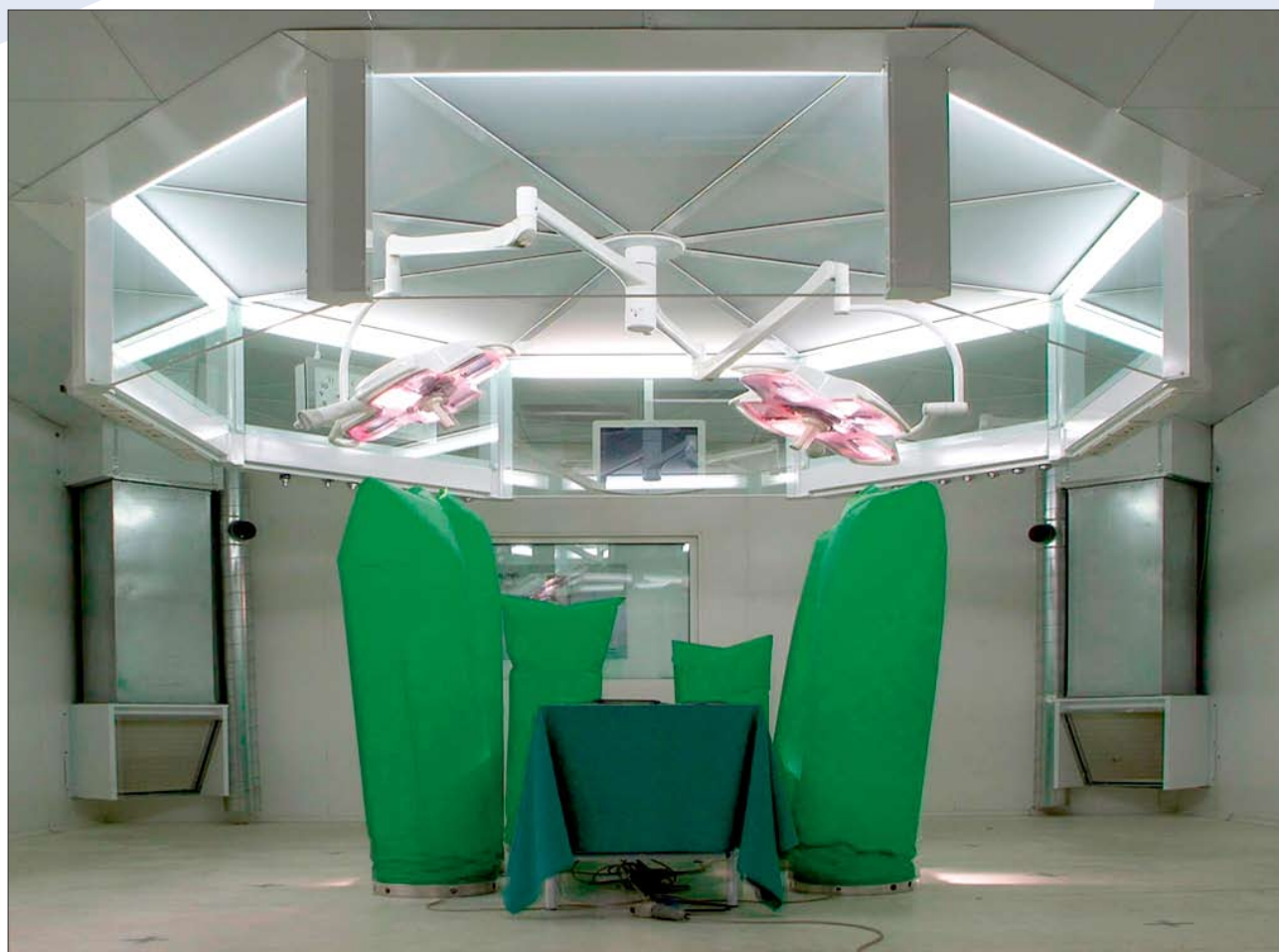
Рис. 13. Ламинарный потолок. Общий вид
