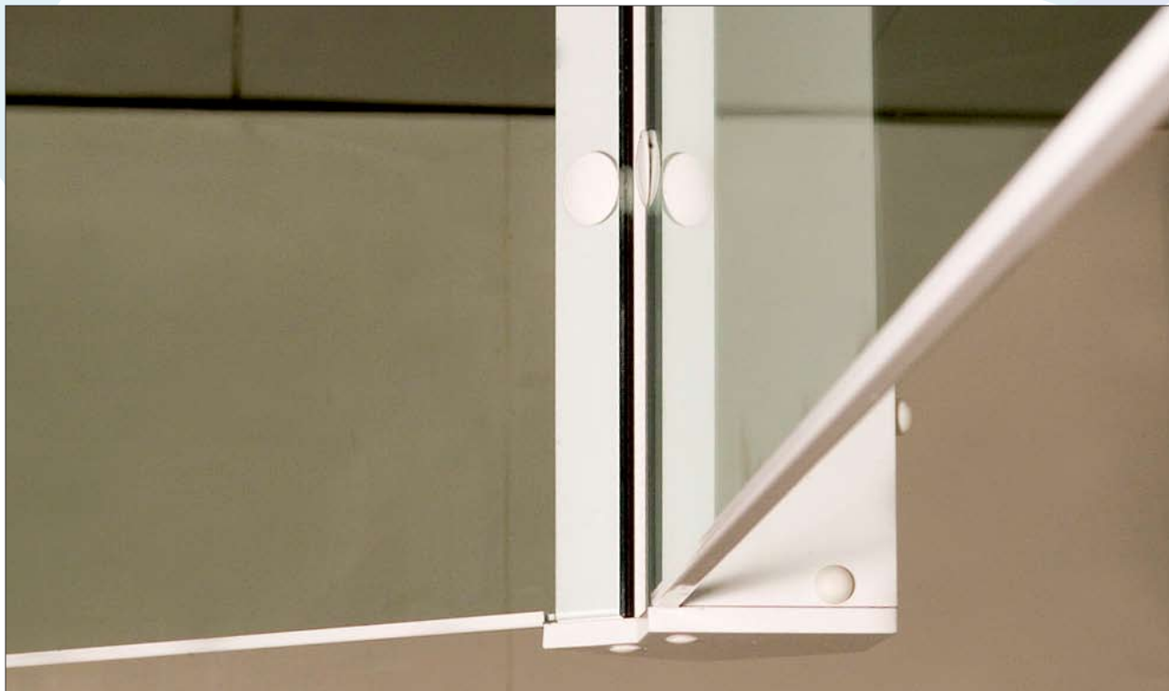
Рис. 16. Конструкции боковых ограждений
