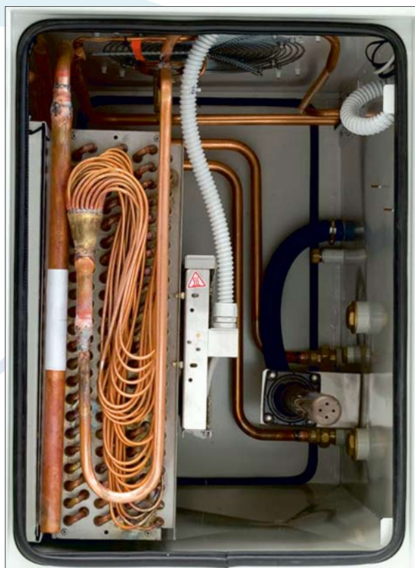
Рис. 11. Элементы холодильного контура имеют минимум паяных соединений для предотвращения утечек хладагента и удобства стерилизации аэродинамического тракта кондиционера изнутри
