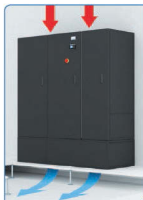
Пример установки нижнего коллектора
