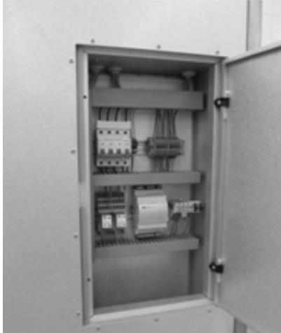
Корпус устройств автоматического управления встроен в секцию охлаждения и снабжен дверцей для осмотра и обслуживания. Доступ к нему возможен во время нормальной работы агрегата. Агрегат оснащен штуцерами для заправки и проверки давления в контурах охлаждения. Корпус снабжен утвержденным замком панели управления, открывать который может только уполномоченный персонал. Преобразователь частоты расположен в секции агрегата, в которой его данные можно считывать через окно в двери.
