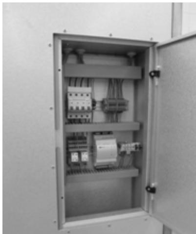
Корпус устройств автоматического управления встроен в секцию охлаждения и снабжен дверцей для осмотра и обслуживания. Доступ к нему возможен во время нормальной работы агрегата. Агрегат оснащен штуцерами для заправки и проверки давления в контурах охлаждения. Корпус снабжен утвержденным замком панели управления, открывать который может только уполномоченный персонал. Преобразователь частоты расположен в секции агрегата, в которой его данные можно считывать через окно в двери.
