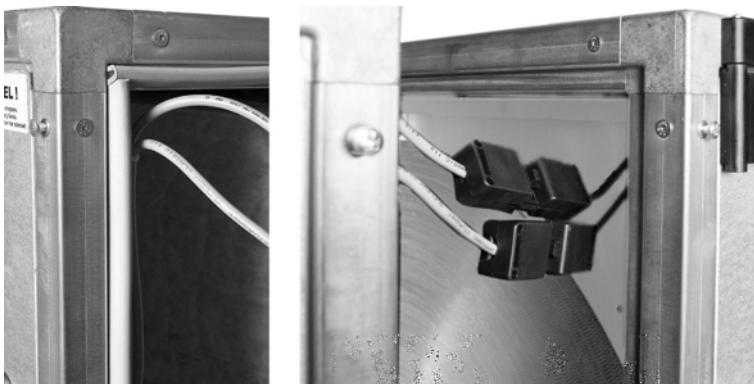
Установка секции охлаждения на другие агрегаты осуществляется с помощью устройства Disc-lock и сборочных фитингов для наиболее крупных агрегатов. См. инструкции по установке агрегата. Детали для сборки поставляются в комплекте с агрегатом и находятся в ящике с другими деталями (сифон, ручка и т. п.). Убедитесь в том, что упаковочный материал между деталями находится на месте, а провода/вилки не повреждены. Одновременно можно соединить защелкивающиеся разъемы.
