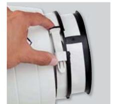
Встановіть корпус вентилятора назад у монтажний кронштейн і закрийте хомути.
