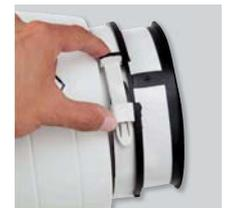
Установите корпус вентилятора обратно в монтажный кронштейн и закройте хомуты.
