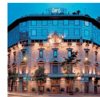
Переоборудование отеля Hotel Claris 5* Барселона, Испания ECOi
