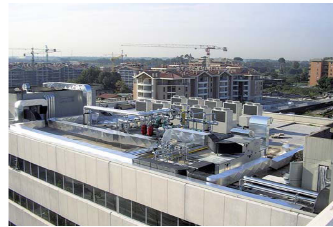
Замена чиллера. Подача холодной воды к фанкойлам.
