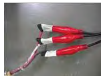
Рис. 2-4 Зажимы, изолированные изоляционной лентой
