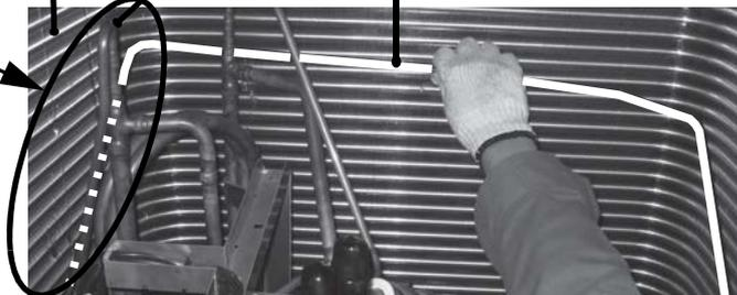
После установки нагревательного устройства основания (перед установкой монтажных кронштейнов нагревательного устройства)
