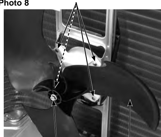
Propeller fan nut
