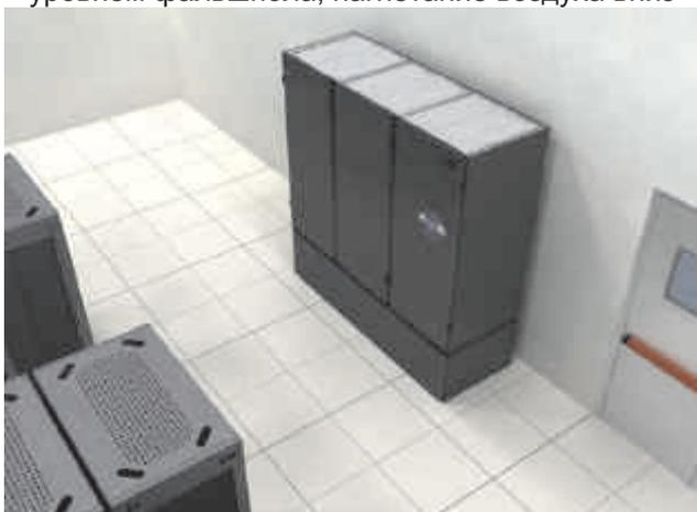
**E - Downflow Down** – с нисходящим потоком воздуха и нижним расположением блока вентиляторов ниже уровня фальшпола
