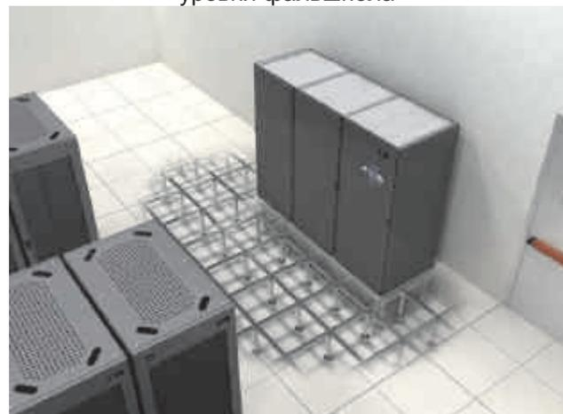
**Варианты исполнения блока с увеличенной высотой и модулем вентиляторов, расположенным над уровнем фальшпола**
