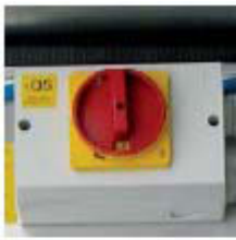
Защитный выключатель. Электропитание 50Гц или 60Гц
