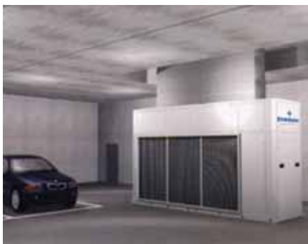
Liebert HPC-R внутри гаража
