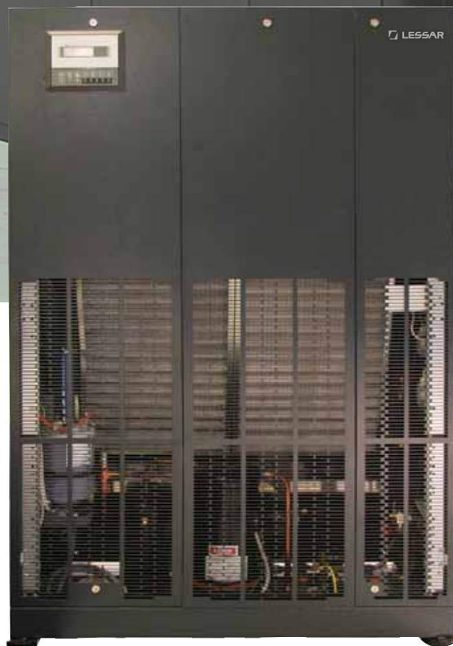
Прецизионный кондиционер. Общий вид агрегата
