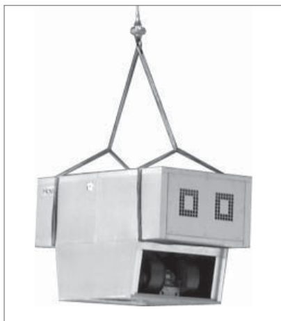
Рис. 15: Крышные установки RoofVent® устанавливаются с уровня крыши.
