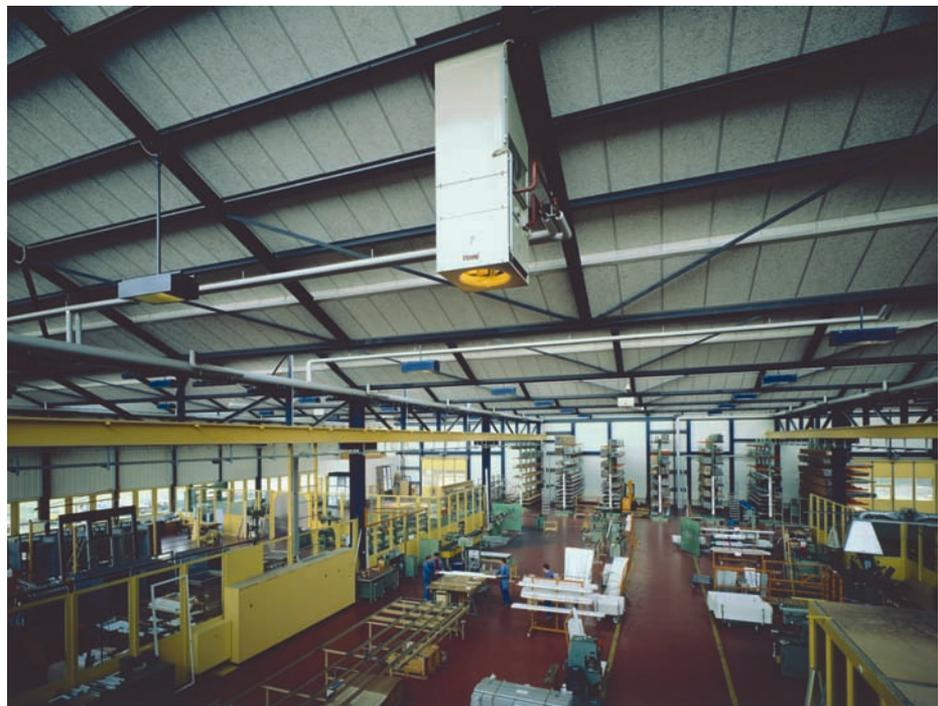
Блоки с подачей свежего воздуха монтируются на крыше, обеспечивая экономию полезной площади
