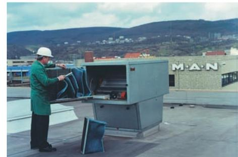
Приточно-вытяжной агрегат LHW легко обслуживается со стороны крыши
