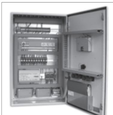
Рис. D4-1. Вид панели зонального управления
