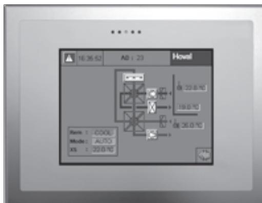
Рис. D3-1. Управление при помощи сенсорной панели DigiMaster
