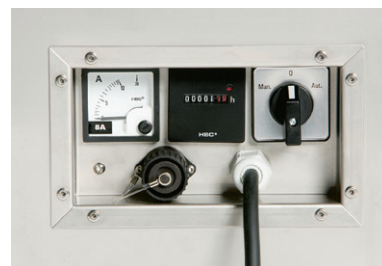
Рис. 10. Панель управления AD 240...400 B.
