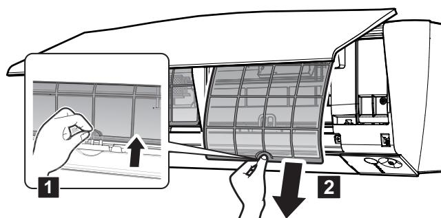
**Примітка: (класи 50~71)** Перед очисткою повітряного фільтра фільтр видалення запаху з титанового апатиту та срібний очисний фільтр для видалення алергенів НЕОБХІДНО зняти.
