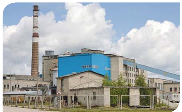
Картонная фабрика, Житомирская обл. г. Малин
